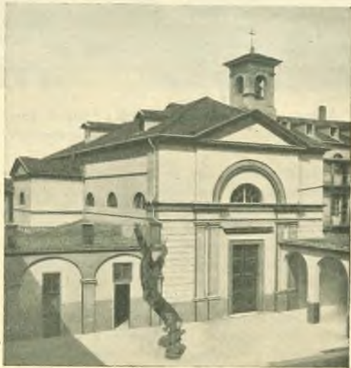
Torino. - Cappella di S. Francesco di Sales, (eretta nel 1852) ove D. Bosco tenne la prima conferenza ai Cooperatori torinesi il 16-5-1878.
