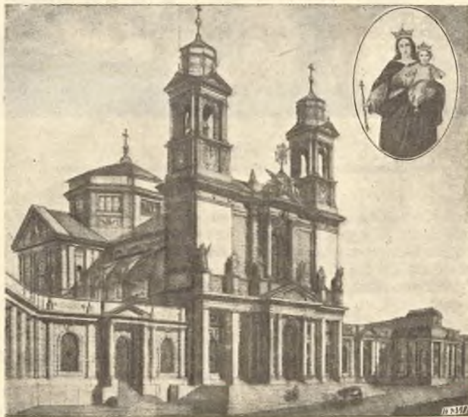
Roma. — Tempio di Maria S. S. Ausiliatrice, in costruzione accanto all'Istituto Pio XI, monumento della munificenza pontificia e della gratitudine salesiana.
